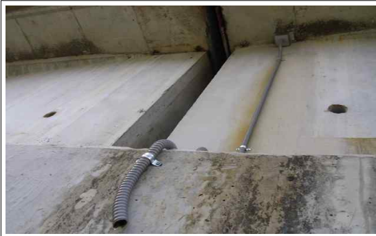
배수시설 상행선 S7(P6) 유도배수관 보수
