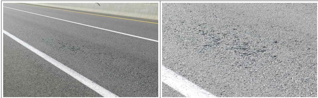
교면포장 상행선 S5 라벨링
