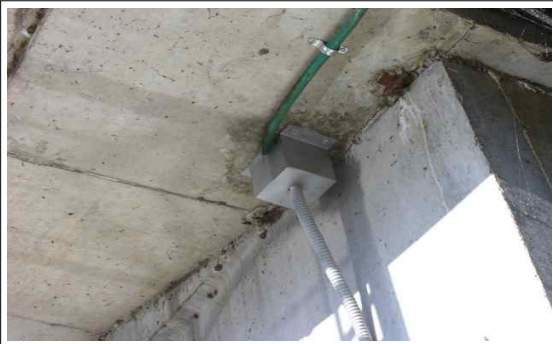
배수시설 하행선 S7(P6) 유도배수관 보수
