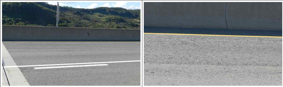
교면포장 상행선 S1 라벨링
