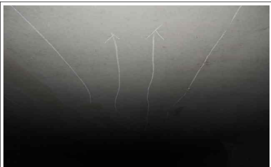
주형내부 상행선 S9 상면 종방향 균열 (CW=0.1mm)
