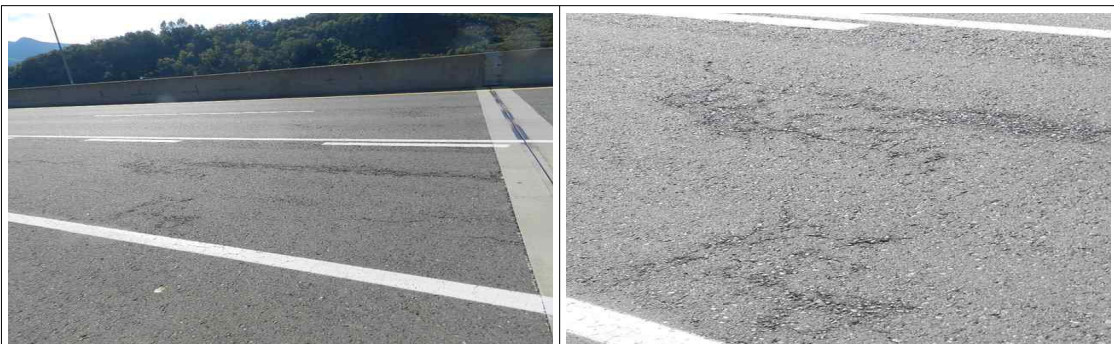
교면포장 상행선 S2 라벨링
